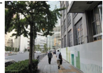
③ 右手には改修工事中の『大阪中央郵便局』があります。
